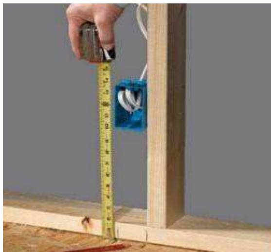
Figura 28: Marcando a localização e as dimensões de caixas elétricas no chão.
