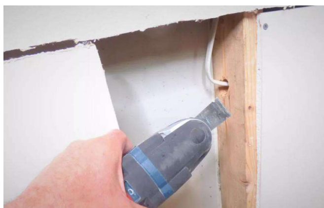
Figura 34: Instalação elétrica em montante de madeira
