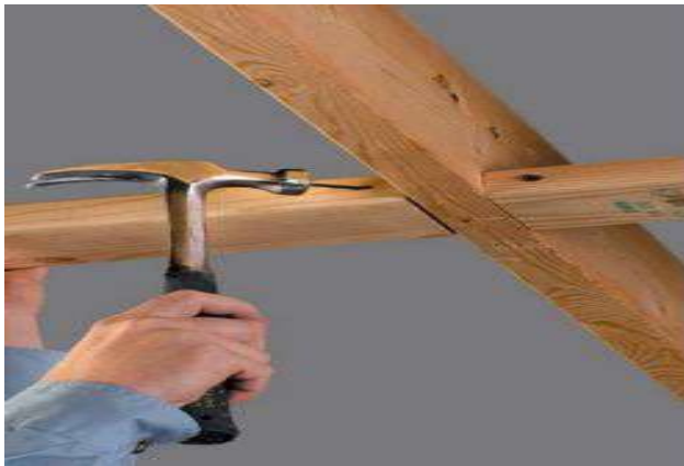
Figura 30: Adicionando bloqueio cruzado com espaçamento.
