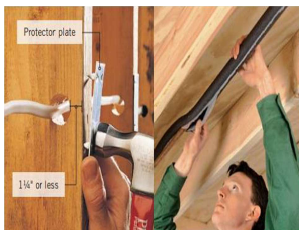
Figura 27 – Instalando placas protetoras e Canos
