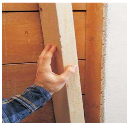
Figura 29 - Adicionando o apoio para as bordas do painel.
