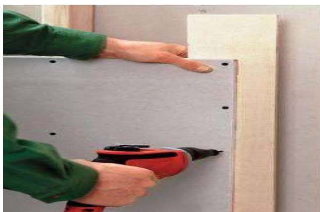
Figura 33: Fixando as chapas nos montantes.
